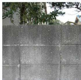
Before (洗浄後に施工)
